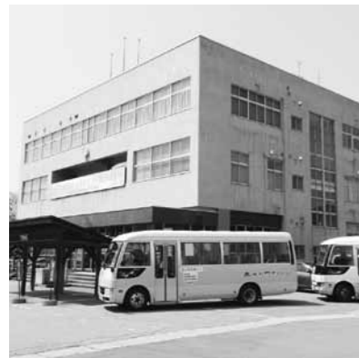
改築が予定されている中央公民館
