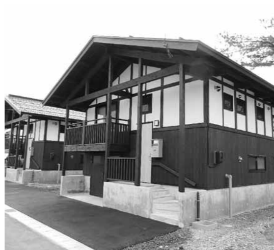
金山型住宅（街なか公営住宅）
