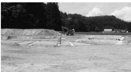
建設中のめごたまた園舎
