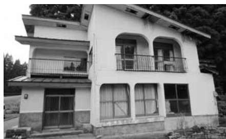
解体を待つばかりの空き家
