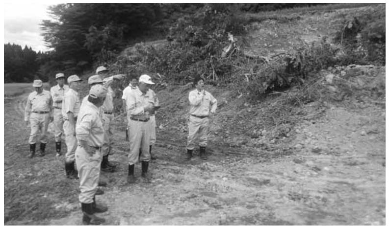
被災した農地を調査
