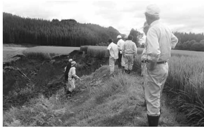
被災した農地を調査
