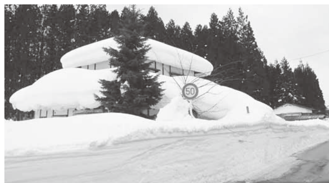
降雪期の危険空き家
