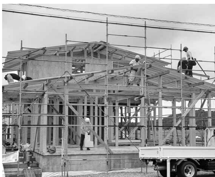
建設中の金山住宅
