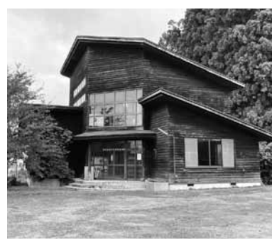
明安地区多目的集会施設
