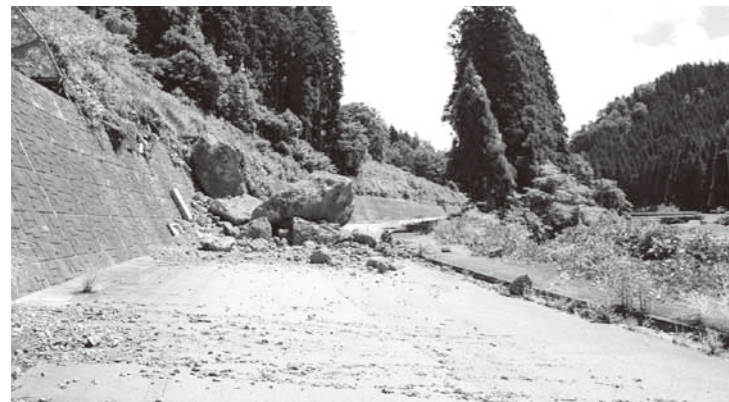
記憶に新しいH30.8月豪雨災害（榎沢ダム付近）
