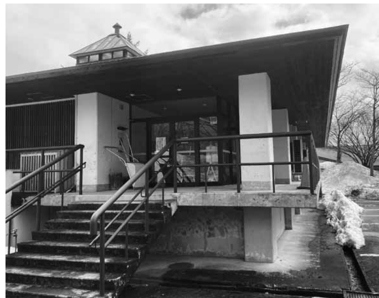
老人福祉センター・やくし苑段差
