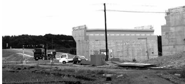
高規格道路工事現場
