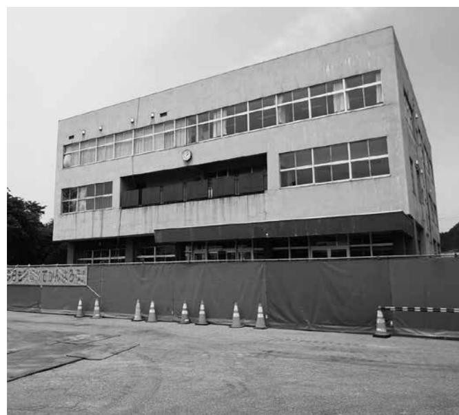
旧中央公民館解体現場
