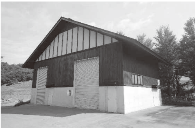
チップボイラー建屋
