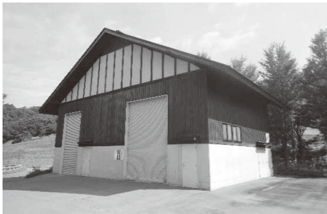
チップボイラー建屋
