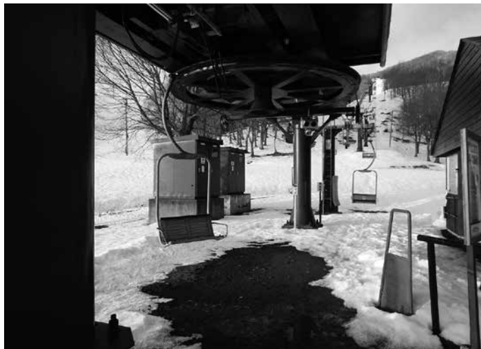
神室スキー場のリフトの点検は
