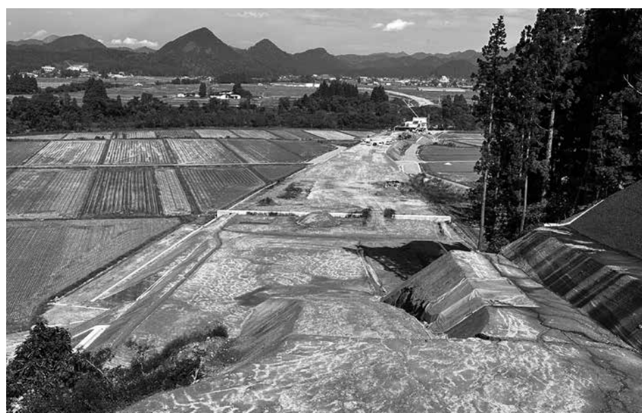
工事が進む高規格道路
