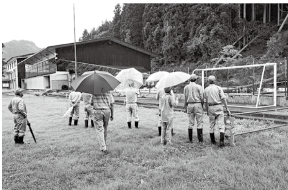
崩落した金山小学校裏山
