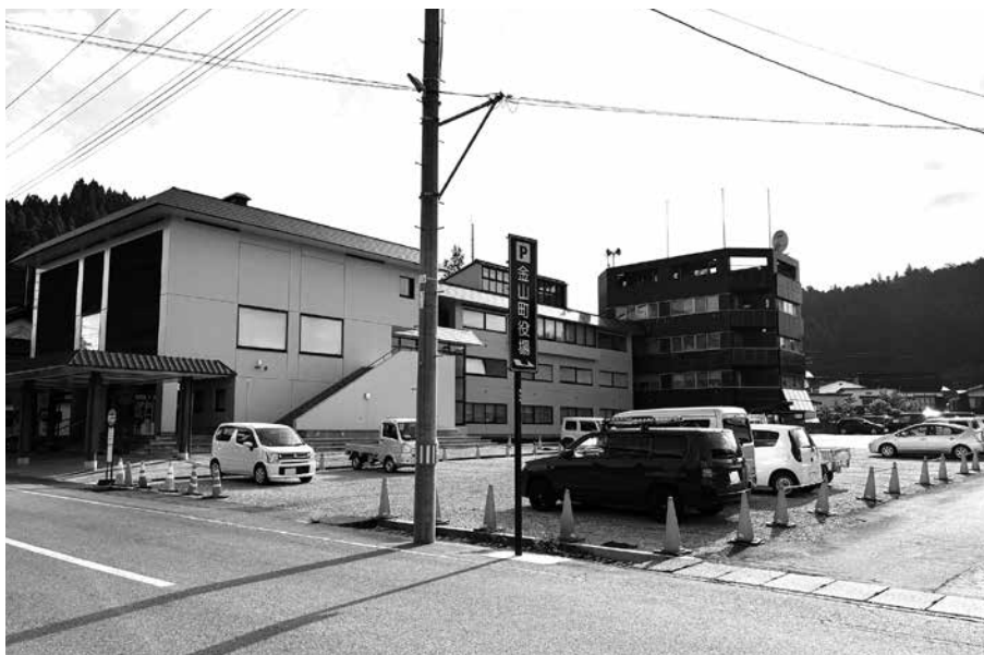
非常用発電装置設置予定地
