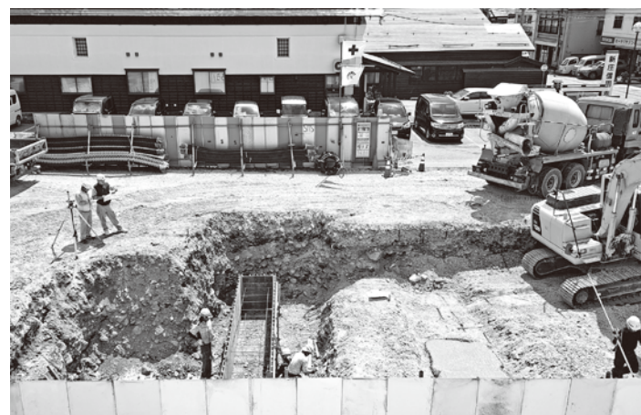
工事が進む非常用電源設備
