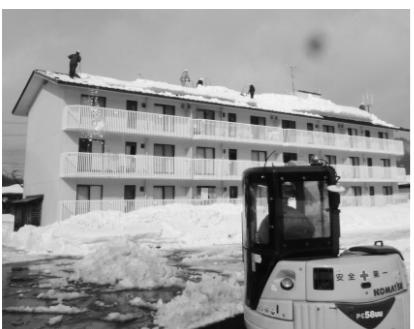
町営住宅の雪下ろし風景
