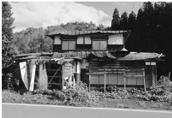
行政代執行により解体された危険空き家(解体前)
