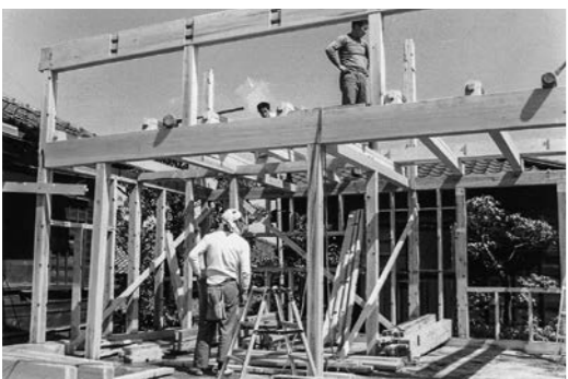
▲1970年私の家建設中の和田啓棟梁、大工・斎藤吉見君、樋渡二郎君
