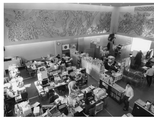
▶2017年3月耐震補強工事中の町役場2階町民ホールを生き生きと上手く活用している事務部局。3階吹抜け部から見下ろす。
