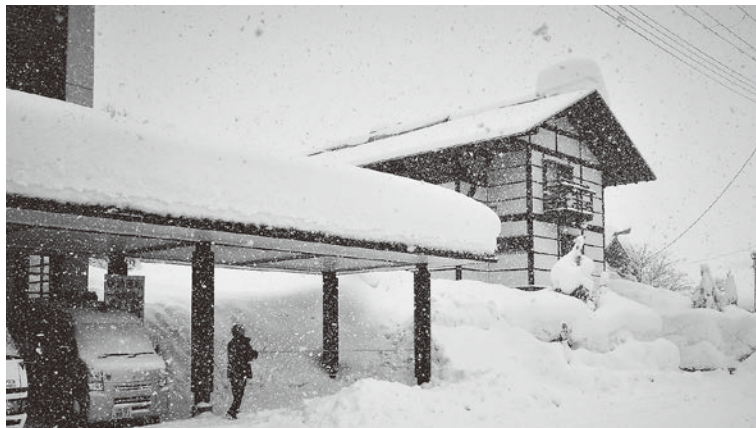
▶約60cmの降雪で積もった役場庁舎車寄せの状況と、雪止め無しで建築された役場庁舎屋根と勾配の二十の家の落雪状況。
