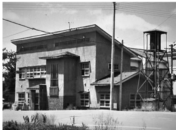
▲戦後に再建された、木造モルタル仕上げの金山町立病院外観
