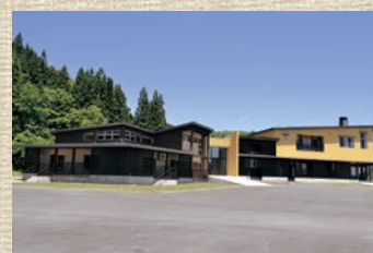
⑧園庭・外構工事が完了し、ついに7月に開園。
