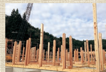
⑤造成工事を経て、昨年6月から始まった建設工事。
