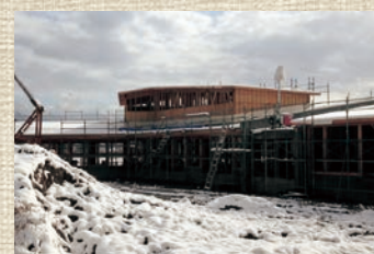
⑦建設工事は冬期間も休まず続けられた。
