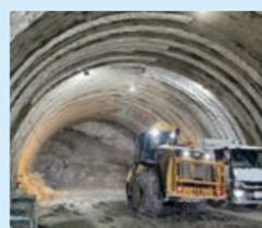
現在、昼夜でトンネル掘削をしています。先端は柔らかい地質の為、地山を薬液で固めながら30m/月程度で掘り進み年内の貫通を目指しています。
