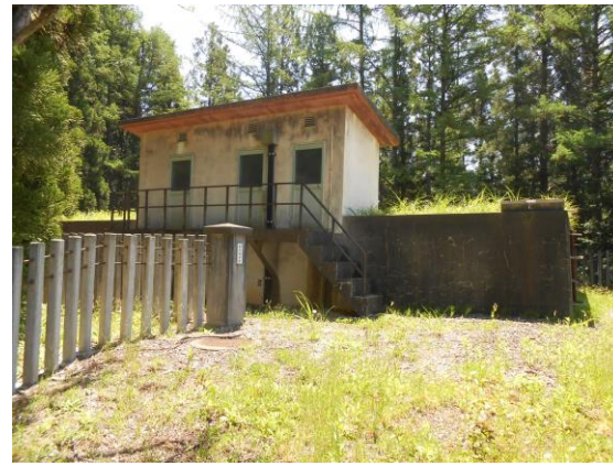
既設羽場配水池
