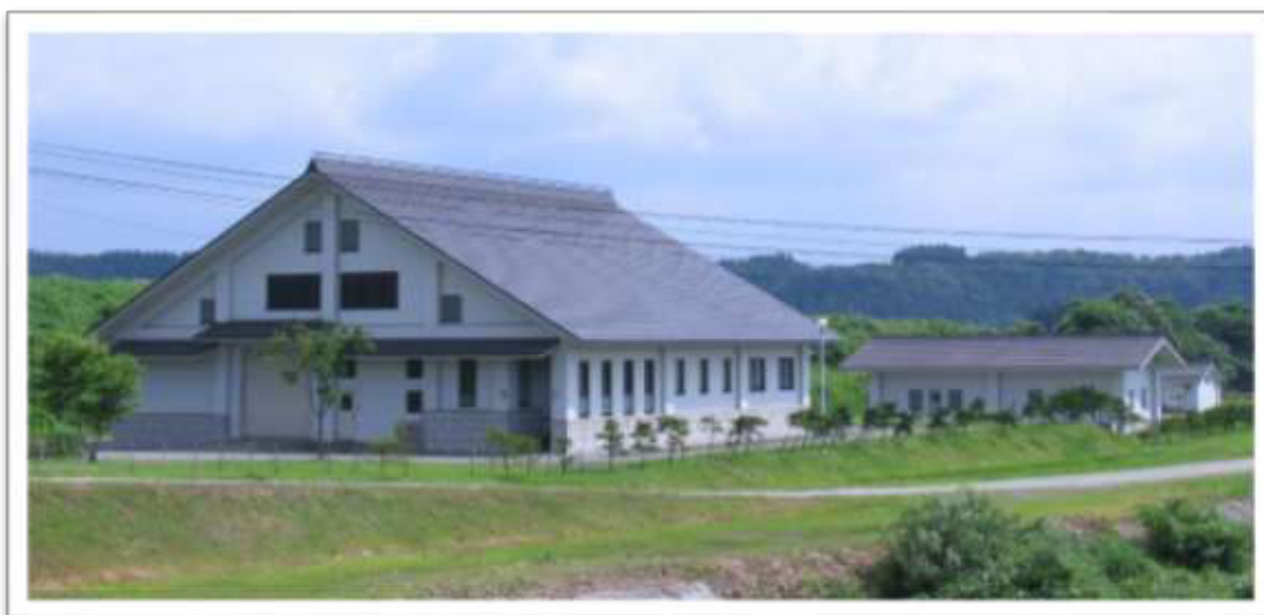
写真：金山浄化センター
