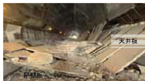
写真-4 天井板崩落状況②
