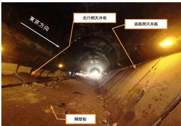
写真-3 天井板崩落状況①
