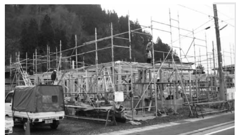
十日町地区建築着工した街なか公営住宅
