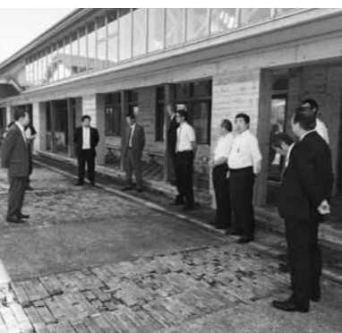
明安小学校中庭木タイルの劣化状況を確認
