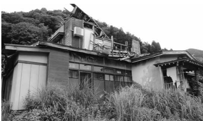
今年10月に解体された危険空き家（解体前）
