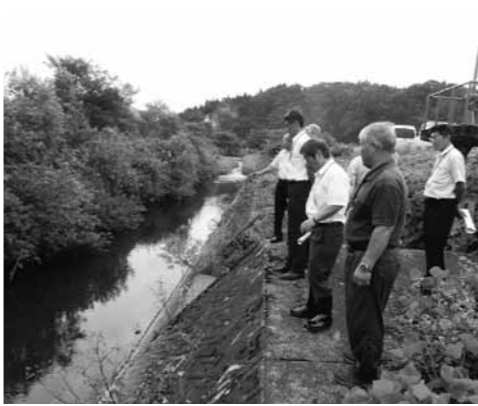
上台川河床整正・支障木伐採請願現地調査(9/12)
