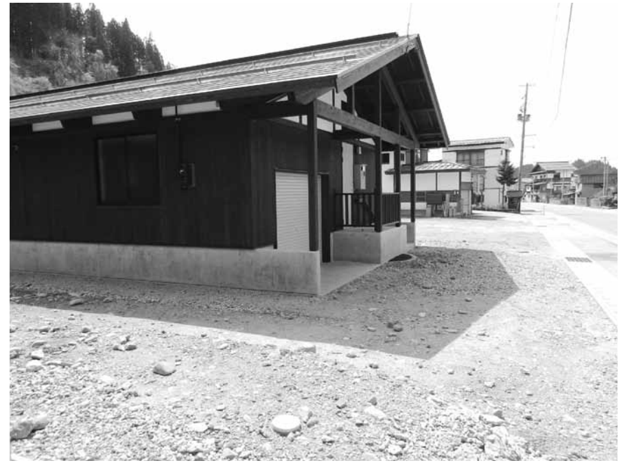
外構工事が28年度へ繰越(街なか公営住宅)
