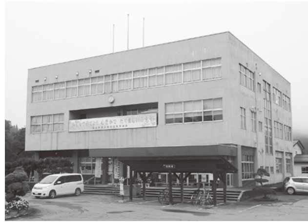
改築計画が進む中央公民館
